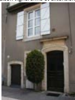
Figure 114 - Maison vigneronne (Porte de cave à gauche)
