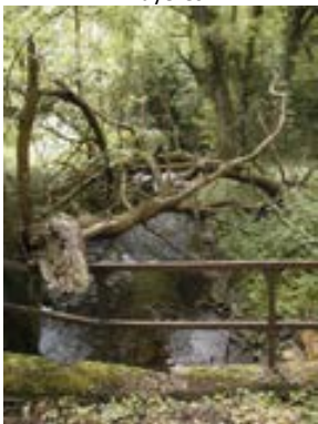
Figure 124 - Le ruisseau de Montvaux (Chemin de Goglo) avant restauration
