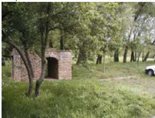
Figure 90 - Le site actuel vu de la rue des Thermes
