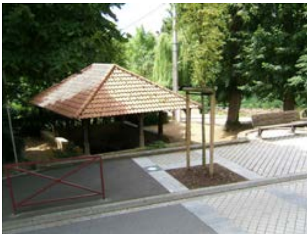
Figure 102 - Traitement du RD103d - Grand'Rue
