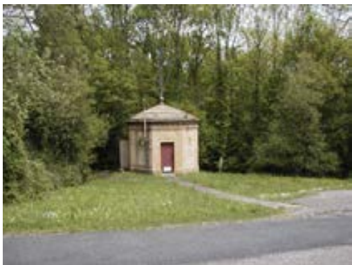
Figure 122 - Bâtiment d'accès au siphon de l'aqueduc rue des Bruyères
