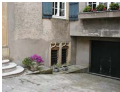
Figure 119 - Grand Rue - Château Buzet : Fenêtre médiévale et portail de garage contemporain
