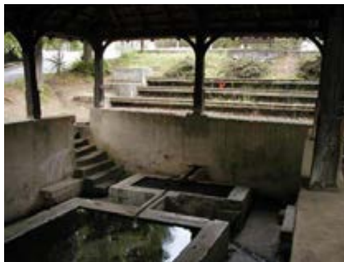
Figure 123 - Le lavoir communal restauré et surplombé par la Grand Rue
