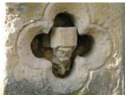
Figure 126 - Détail de façade - Église (Coll. Reitz)
